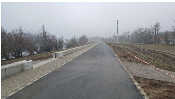
A töltésen vezetett nyomvonal az új árvízvédelmi fallal
